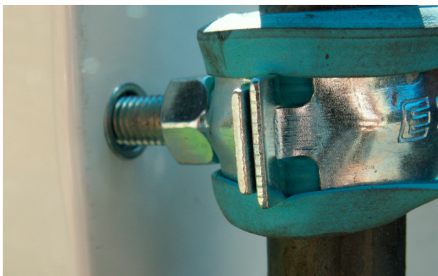
Lähikuva telineen kiinnityksestä kaappiin.
