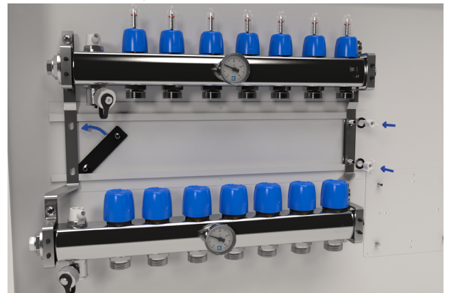
LK Jakotukki RF:n asennus.
