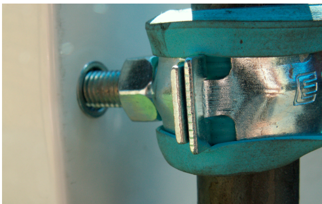
Lähikuva telineen kiinnityksestä kaappiin.
