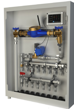
Keskusyksikkö varustettu moottoriventtiilillä ja paineanturilla asennettuna asennuskaappiin.
