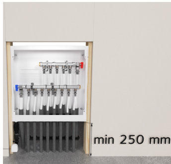
Esimerkki: asennus ilman kiinnityslevyä ja kiinnityslevyn kanssa.
