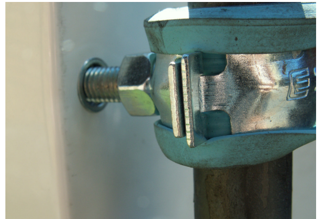
Lähikuva kiinnityksestä kaappiin.
