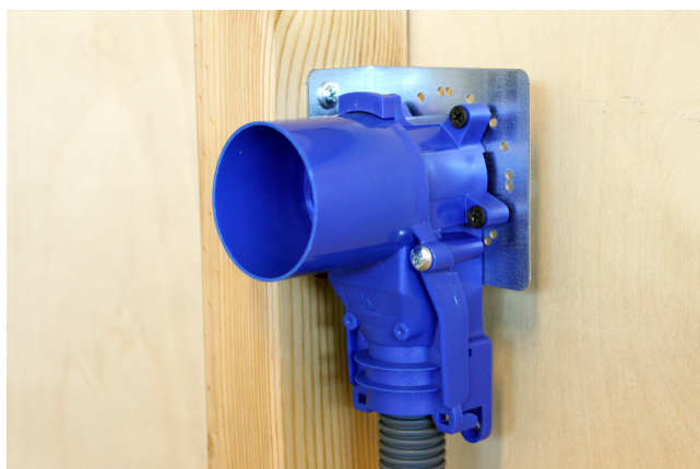
LK Hanakulmarasian kiinnike – 1 asennettuna pystykoolaukseen.
