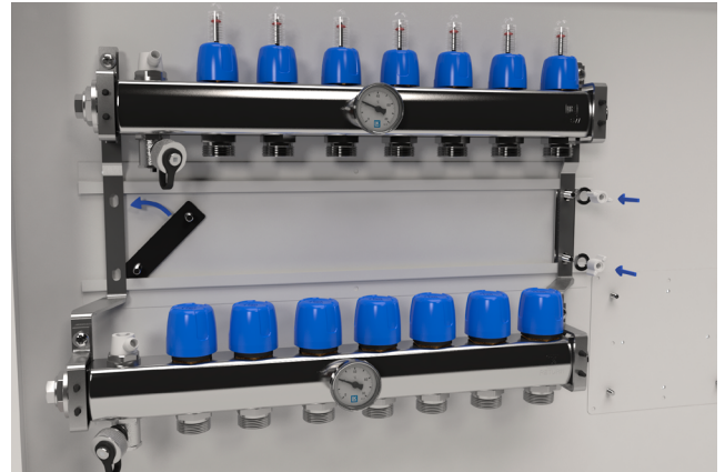
LK Jakotukin RF asennus.
