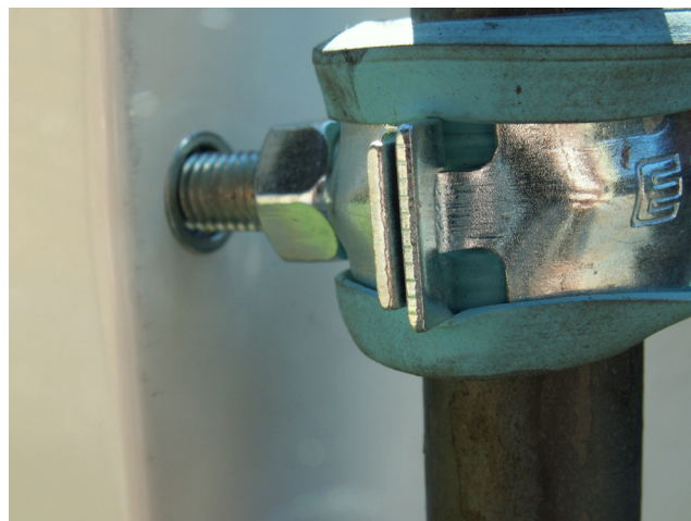
Lähikuva telineen kiinnityksestä kaappiin.
