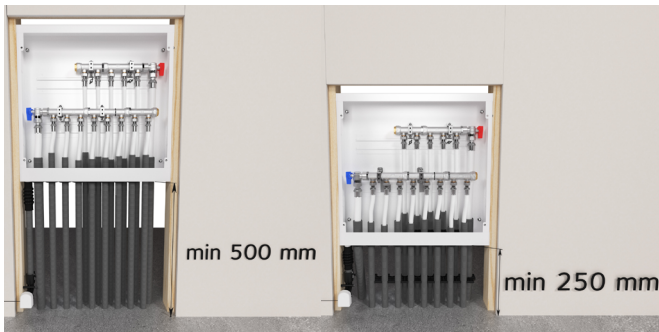
Esimerkki: asennus ilman kiinnityslevyä ja kiinnityslevyn kanssa.
